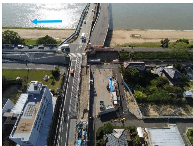
元浜橋拡幅工事(南武橋架替工事)
