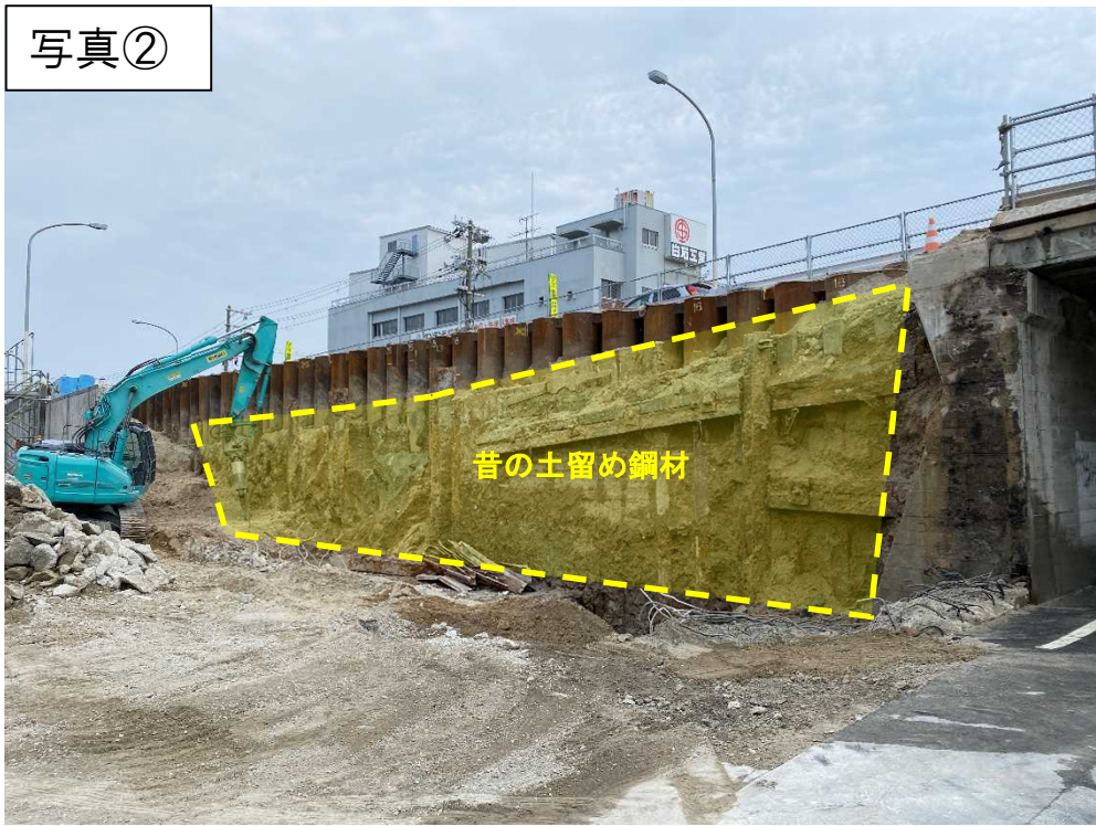
発生した地中埋設物②
