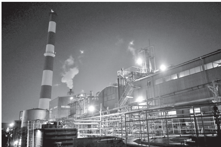
尼崎市南部の工場夜景
